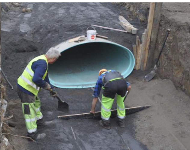
Fot. 5 Profilowanie do kształtu zewnętrznej średnicy dna panelu
