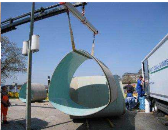
Fot. 2. Przewóz paneli za pomocą taśmy
