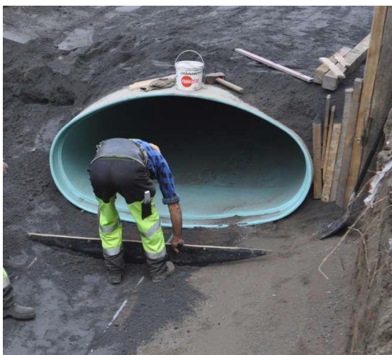
Fot. 4 Profilowanie do kształtu zewnętrznej średnicy dna panelu
