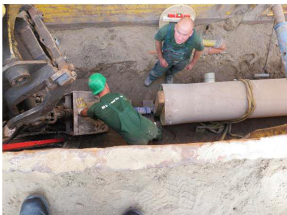
Fot. 6. Niepoprawne zastosowanie drewnianej kantówki
