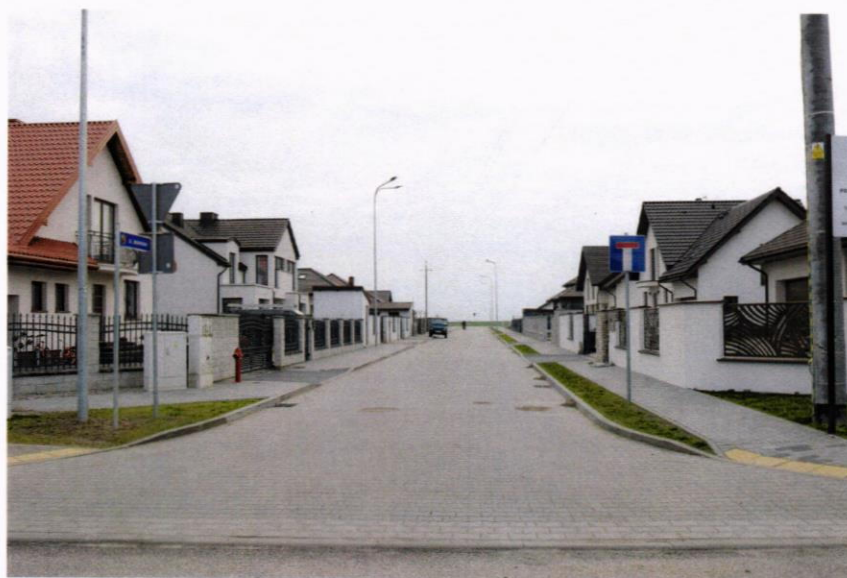
Nowo zbudowana ulica Jesionowa
