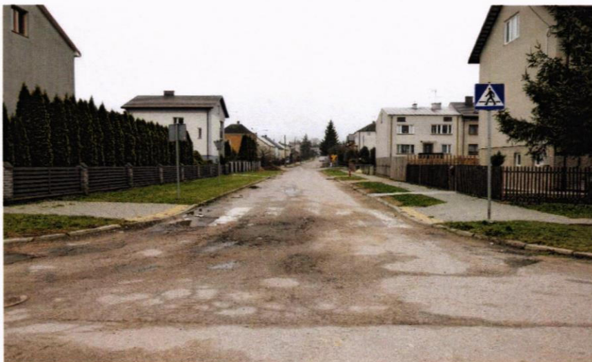
ul. Wesola – zdjęcia obecnej ulicy. Został przekazany plac budowy dla wykonawcy zadania. Prace remontowe rozpoczną się wiosną 2024 r.
