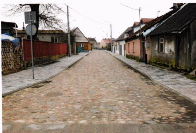
Nowo przebudowana ulica Chopina
