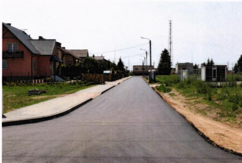
Nowo zbudowana ulica Żurawia
